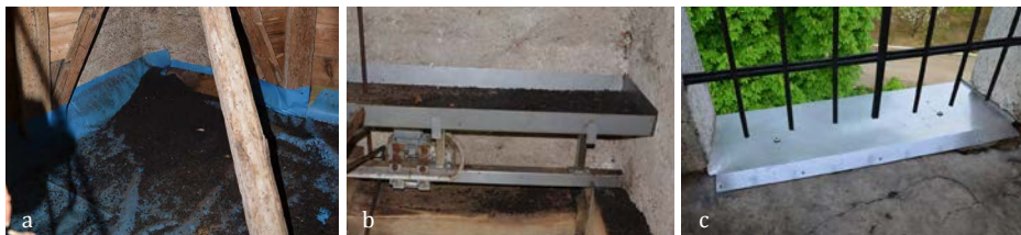
SLIKA 8. a) Izvedeni ukrepi so zadržali večino gvana v predelu nad zvonovi, b) tudi polička nad mehanizmom za zvonjenje nudi ustrezno zaščito, c) zamenjane odkapne police (foto: Simon Zidar).
