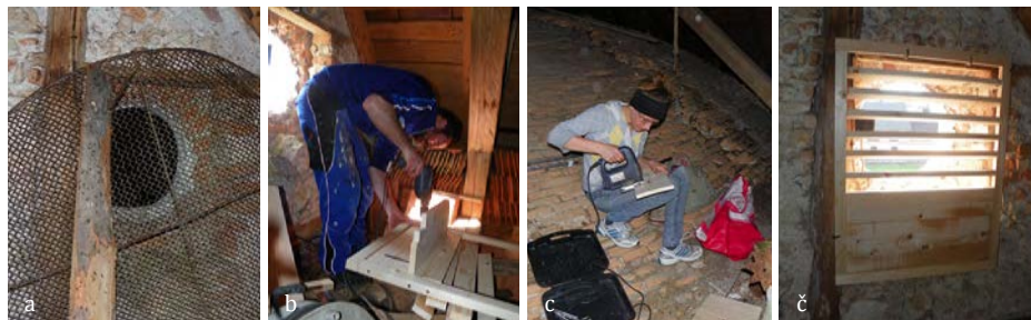
SLIKA 11. a) Na zastrto okroglo odprtino podstrešja smo namestili b) - č) posebno izdelan okvir z vodoravnimi letvicami, ki preprečuje dostop golobom, a omogoča varen prehod navadnim netopirjem (foto: Jasmina Kotnik).
