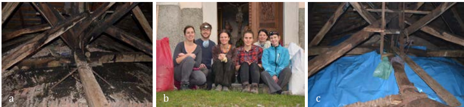
SLIKA 12. a) Pred, b) med in c) po izvedeni čistilni akciji v Dolnjem Suhorju (foto: Simon Zidar).
