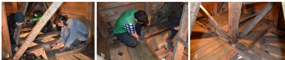
SLIKA 7. Po temeljitem očiščenju zvonika (a) smo se lotili izdelave lesenega podesta (b in c), ki bo preprečeval padanje gvana na zvonove (foto: Simon Zidar).
